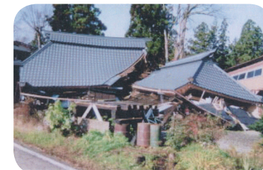
壁が少なかった古い民家の崩壊
