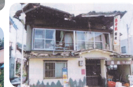
屋根が重過ぎた店舗併用住宅崩壊
